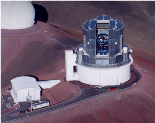
図2 すばる望遠鏡 (NAOJ のホームページより) 日本が誇る、口径 8.2 m の世界最大級の可視光赤外線望遠鏡である。ハワイ島マウナケア山頂 (標高 4,200 m) に設置されており、さまざまな観測装置を用いた天体観測が行われている。
